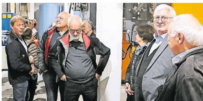
Betriebsleiter Hanspeter Meier (links) zeigte den Besuchern die beiden grossen neuen Heizkessel.
