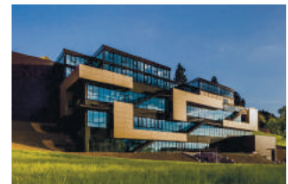
Neubau JUST Schweiz AG Walzenhausen
