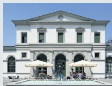
Sanierung Bahnhof Bad Ragaz (2015)
