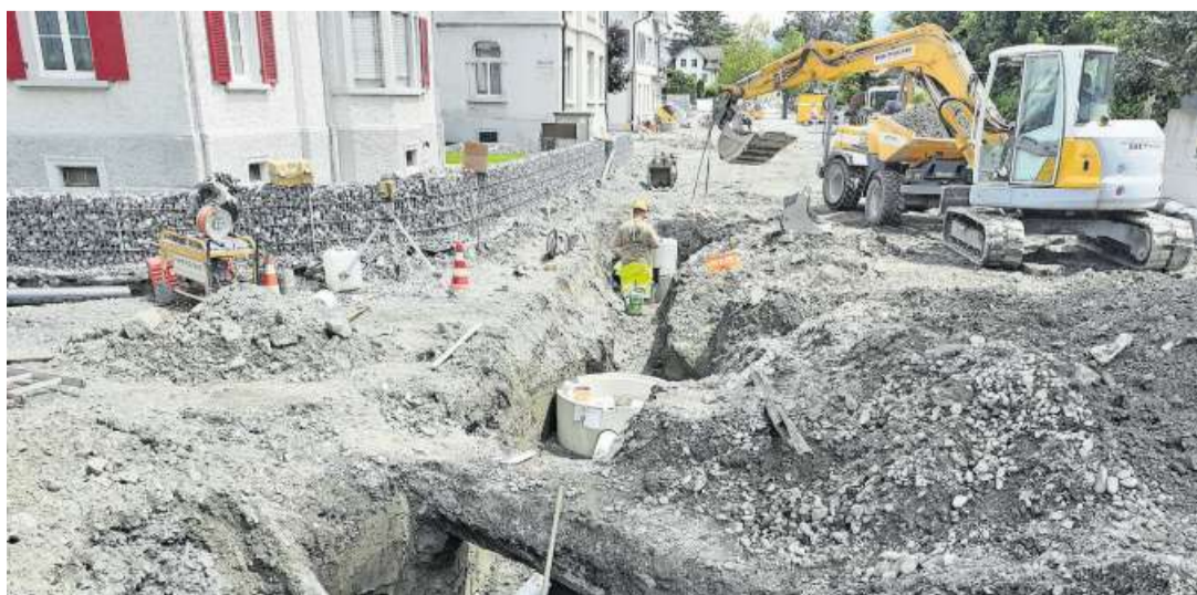
Auch an der Neugasse soll der motorisierte Verkehr verlangsamt werden.
